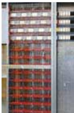
tramite diaframmi isolanti che prevengono l'innescò dell'arco interno, in tal caso il quadro è definibile secondo le normative, "ARC FREE ZONE". Il vano sbarre è segregato metallicamente dai cassettei.
