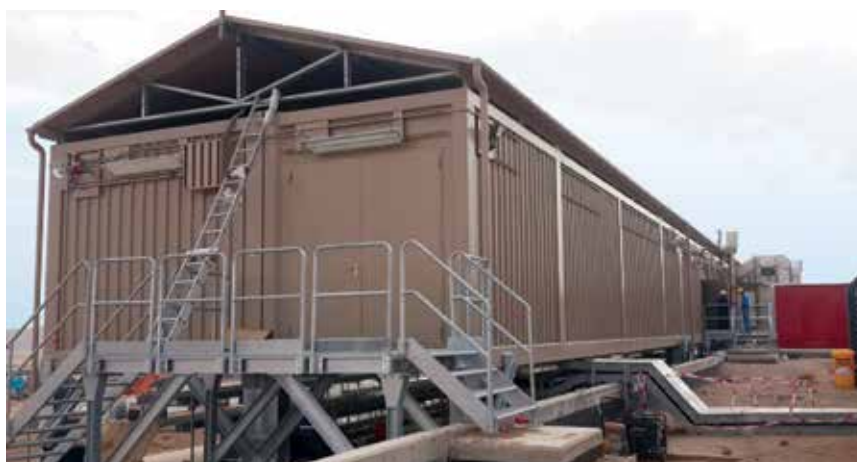
Sottostazione elettrica containerizzata. Cliente: Exterran; Progetto: progetto gas Summail; Stabilimento: Dno kurdistan - Iraq.
