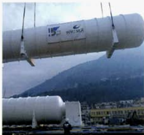
Uno dei serbatoi del gas installati sul traghetto F.A.Gauthier
